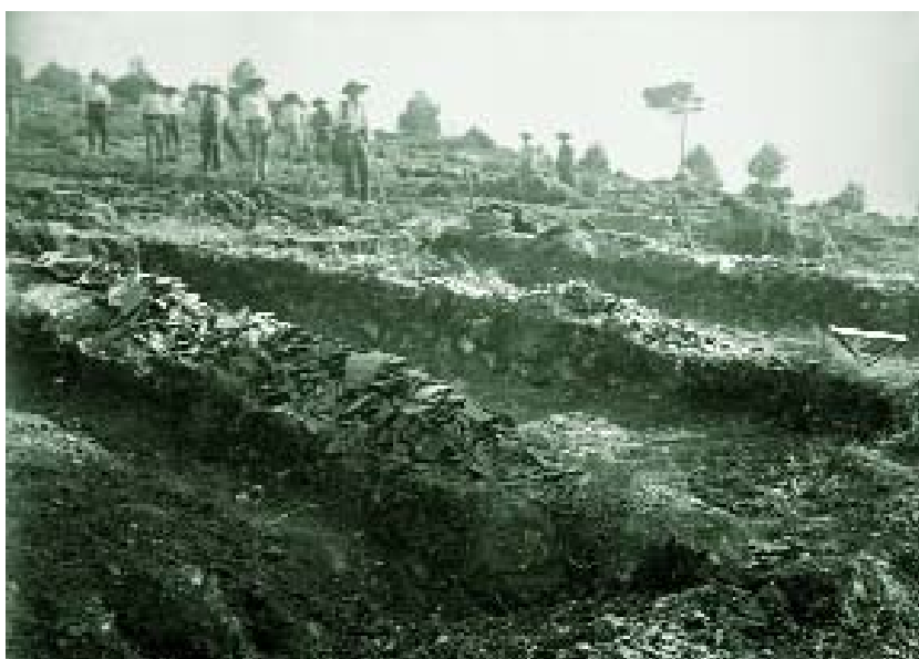
Detalle de la excavación en la Bastida de les Alcusses (Moixent). Los fragmentos de cerámica aparecen amontonados junto a los muros de los departamentos. 1928. [Isidro Ballester. Placa de vidrio. SIP 1.140]
